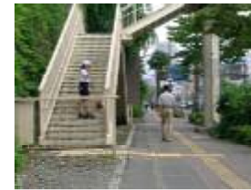
(岡田町信号歩道橋)
